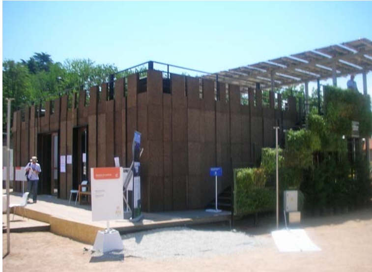
Das zentrale Büro der „Villa Solar“, ausgestattet mit Fenstern der profine- Marke Kömmerling.
